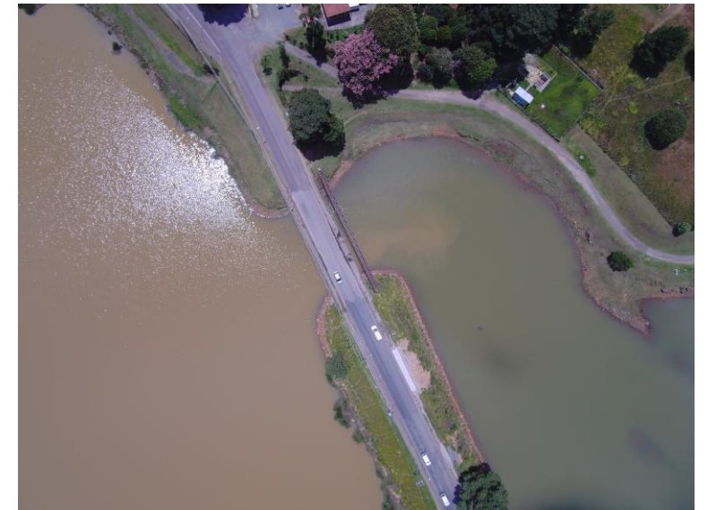
Drohnenaufnahme des Oberlaufs der Passauna Stauhaltung in Curitiba, Brasilien nach einem Starkregenereignis. Foto: T. Bleninger, UFPR
